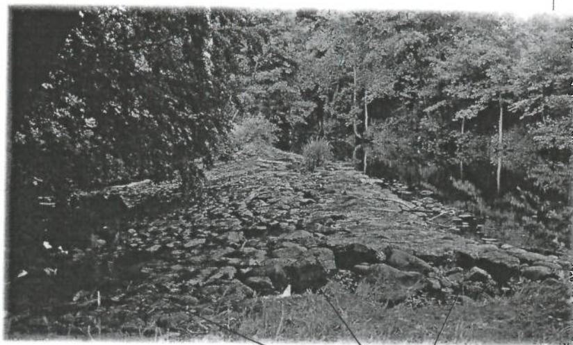
D'une simple pierre manquante, non remplacée à temps, le désordre s'étend rapidement à une **zone importante de la carapace, par effet de dislocation**. Ce scénario de dégradation accélérée est particulièrement à redouter pour les seuils à parements constitués de pierres sèches où la cohésion de la carapace n'est assurée que par l'effet auto-bloquant des blocs les uns vis-à-vis des autres.
