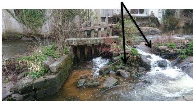
Les différents désordres observés sur les déversoirs seront repris de la même façon. C'est le cas de la déstructuration de la carapace au centre du déversoir aval en prenant en compte l'aménagement projeté pour la montaison des anguillettes – civelles. C'est également le cas de l'affouillement et la déstructuration du déversoir amont en jonction avec le bajoyer gauche du vannage amont.
